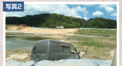
写真2 決壊した小田川の堤防の復旧工事の様子(2018.7.21)
